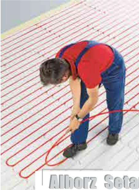
في نظام التدفئة بالرديةتر تكون الحرارة في نقطة ومساحة خاصة، بينما يقوم هذا النظام بالتبادل الحراري عن طريق الشعاع عبر الماء ذي الحرارة منخفضة وهي سائلة في الأنابيب، ولأن الحرارة تتحرك من أرضية الغرفة إلى الأعلى فكل شيء فيها تأخذ الحرارة بنسبة مساوية تقريباً.
